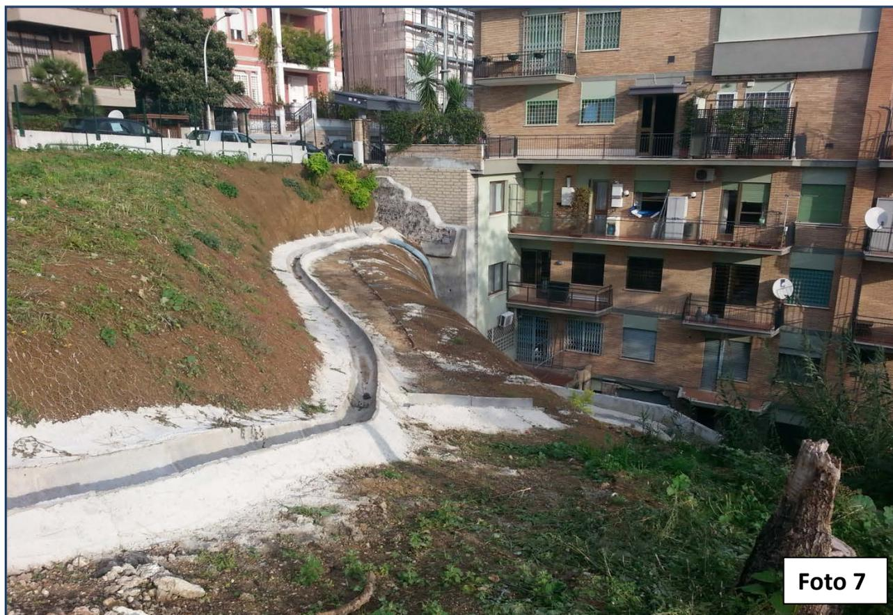
geostuoie (dettaglio foto 8) per la stabilizzazione delle sezioni del pendio intercalate alle gradonature.
